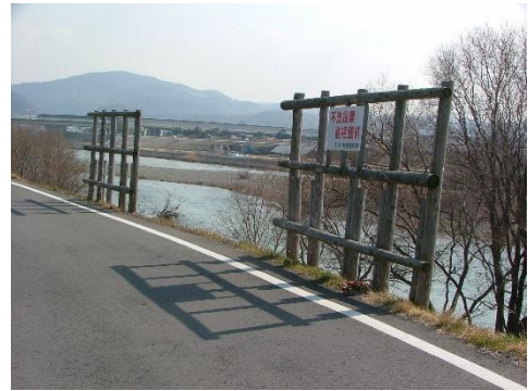
図4 堤防上に設置された柵 2008.2.2
